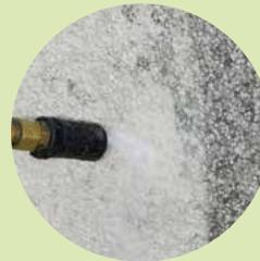
*Vollständiges Entfernen von nicht tragfähigen Substanzen und Verschmutzungen (z.B. durch Nass-Strahlen) unter Beachtung der entsprechend geltenden Vorschriften.*
