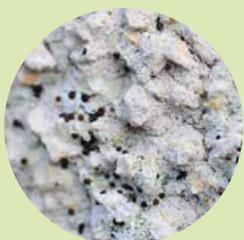
*Trockene, nichtsaugende Oberflächen mit Capatox\* vorbehandeln (je nach Befall 1x bis 2x nass in nass mit Bürste), bei trockenen, saugenden Oberflächen 1x FungiGrund\* auftragen (bei hohem Befall 1x mit Capatox\* vorbehandeln). 24 Stunden einwirken lassen, nicht nachwaschen.*
