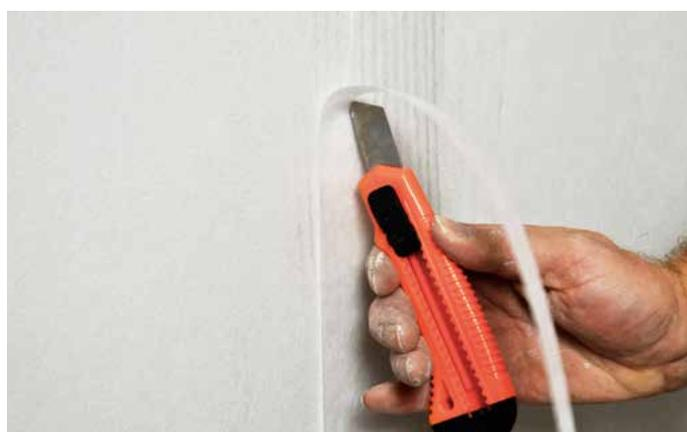
4 Die nächste Bahn wird überlappend angelegt und per Doppelnahtschnitt angepasst. Im Anschluss wird der Nahtbereich nachgeglättet.
