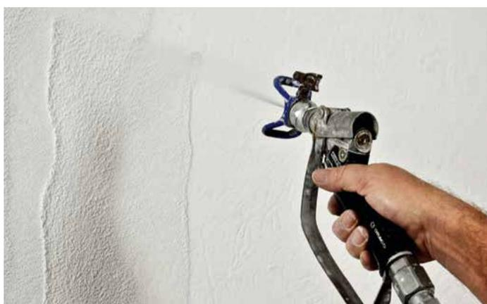
1 Caparol Innenspachtel als Einbettmaterial in einer gleichmäßigen Schicht satt auflegen. Dieses kann im Hand-, Roll- oder wie hier im Spritzauftrag mit leistungsfähigen Airless-Geräten rationell erfolgen.
