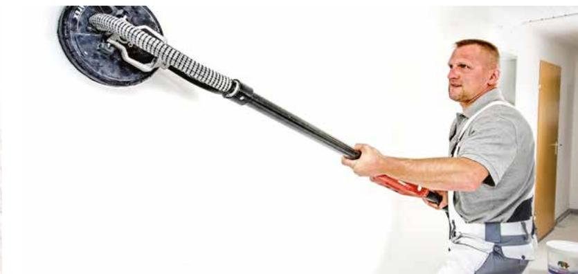
Die Verarbeitung mit der Rolle ist eine nicht alltägliche Herangehensweise an Spachtelarbeiten. Sie füllt die Lücke zwischen herkömmlicher Hand- und rationeller Spritzanwendung. Gerade mittelgroße Flächen in bewohnten Objekten lassen sich so einfach und kräfteschonend bearbeiten.
