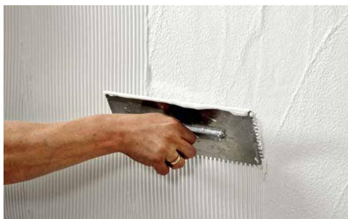
2 Die aufgelegte Spachtelmasse wird mit einer Zahnkelle gleichmäßig durchgekämmt. Fehlstellen sind unbedingt zu vermeiden.
