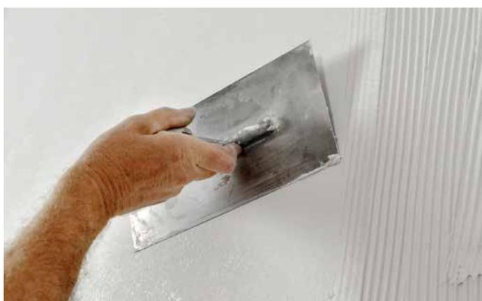
3 Das AkkordVlies G45 SP wird in das nasse Material eingebettet und mit einer Glättkelle einheitlich nachgeglättet. Im Nahtbereich werden ca. 5 cm nicht angedrückt.
