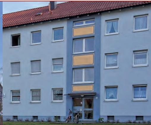
Im Rahmen der Modernisierung wurden die Fassaden mit einem WDV-System gedämmt und sämtliche Dächer erneuert.
